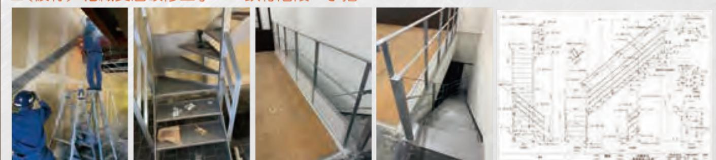
この度アースゲイン様からご注文いただいたのは、倉敷美観地区内(仮称)花織支店改修工事の鉄骨階段・手摺です。コーナーのある曲がり階段のため、設計・製作・施工共にとても苦労しましたが、上手く納まりホッとしています。今回は現場採寸→打合せ→承認用の図面提出→製作→塗装→施工と一貫して対応させていただきました。もちろん一部の工程のみでも対応させていただきますので、お気軽にお問合せください。
